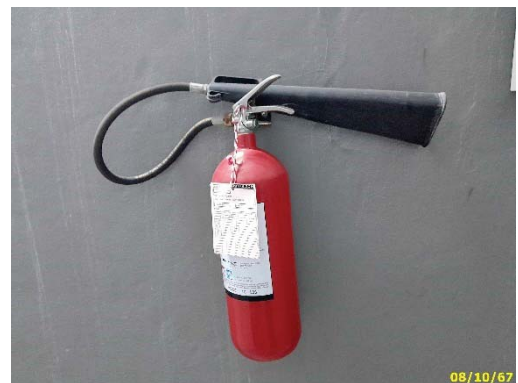
ถังดับเพลิงมือถือ แบบ CO 2
